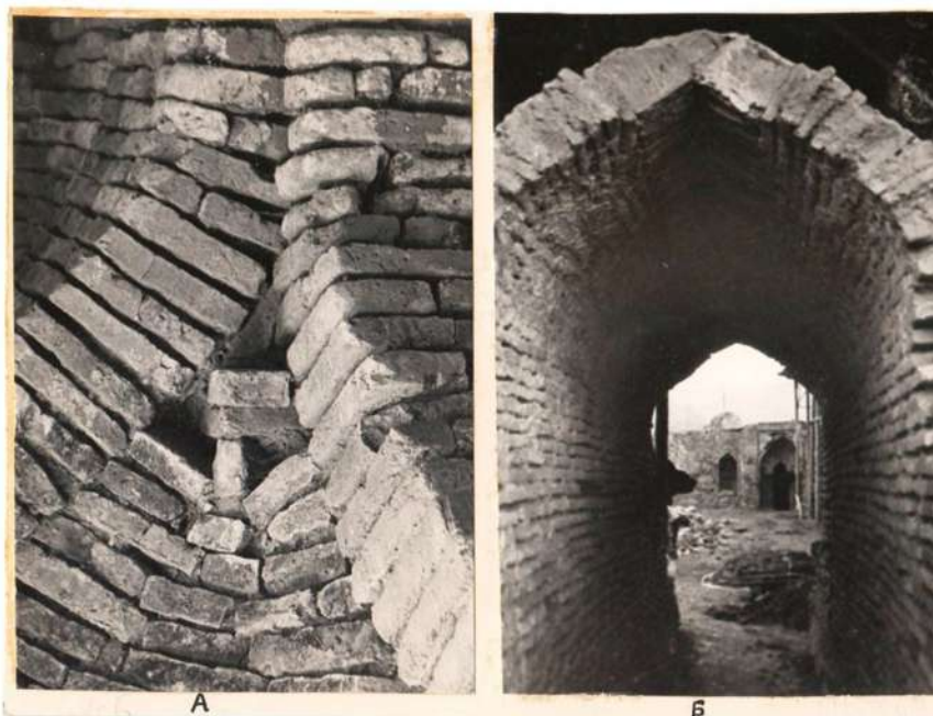
Рис. 114. Медресе Кухна. А: Системы кладки интерьера угловых худжр; Б: кладка восточного прохода.
