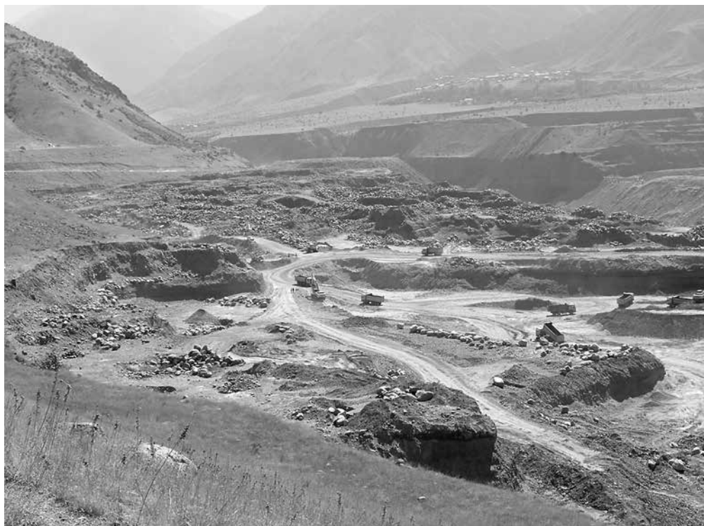
Строительство Рогунской ГЭС. 2017 г. Фото Н. А. Дубовой
