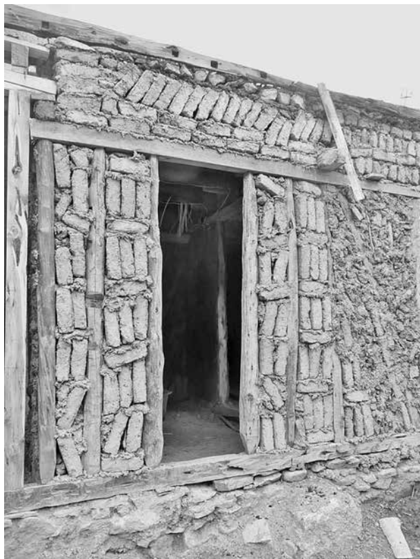
Кладка стены строящегося дома. д. Вору, Верховья Зарафшана. Фото Л. Додхудоевой. 2019 г.
