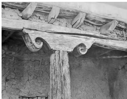
Деревянная капитель (Пенджикентский район) (фото В. Л. Ворониной из архива Р. Г. Мурадова)
