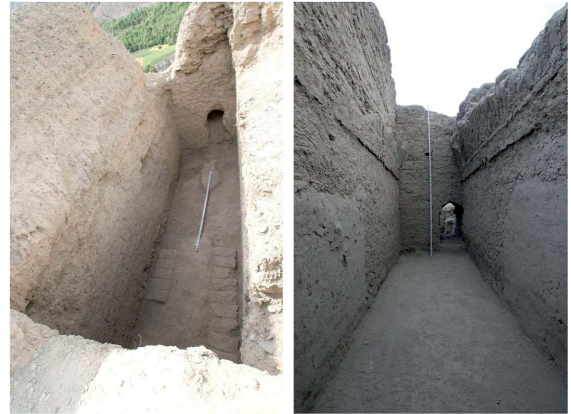
Рис. 58. Сводчатые помещения I этажа
