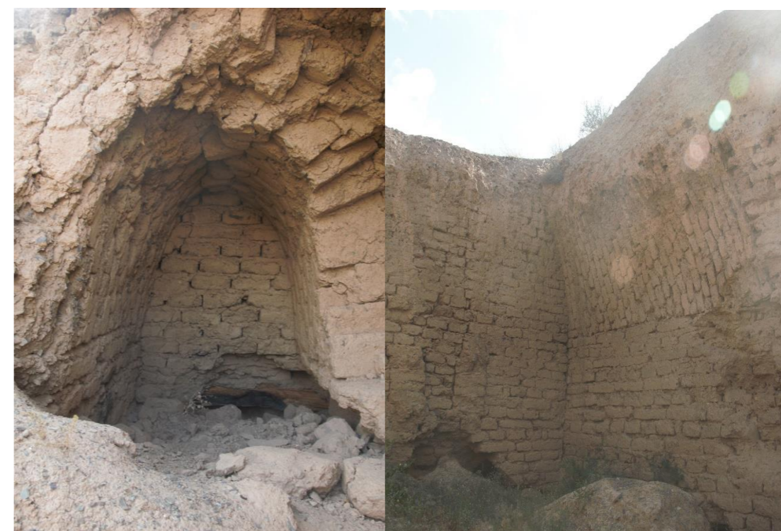
Рис. 56. Кум - кирпичные стены и сводчатые ниши (фото Якубова 2011 г.)
