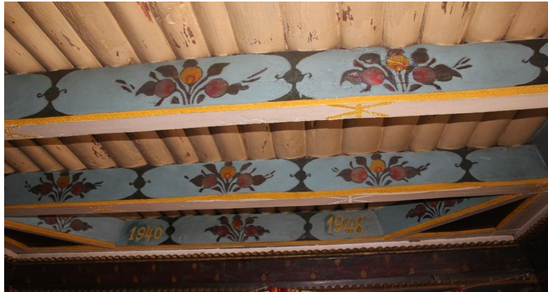
Рис. 45. Потолочно-балочное покрытие комнаты служителя мечети (Фото ПАЭ)
