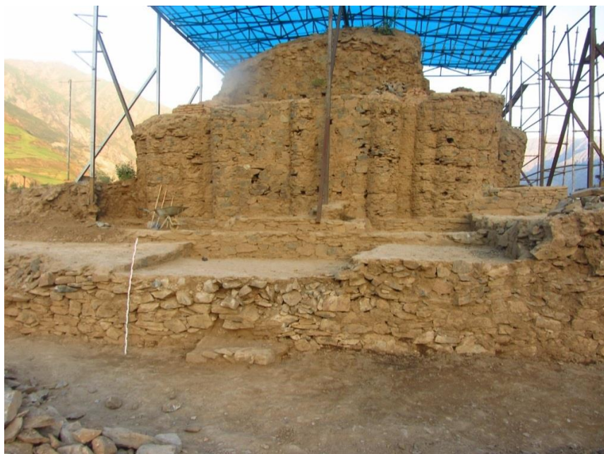
Рис.6. Восточный фасад башни огня в Кароне
